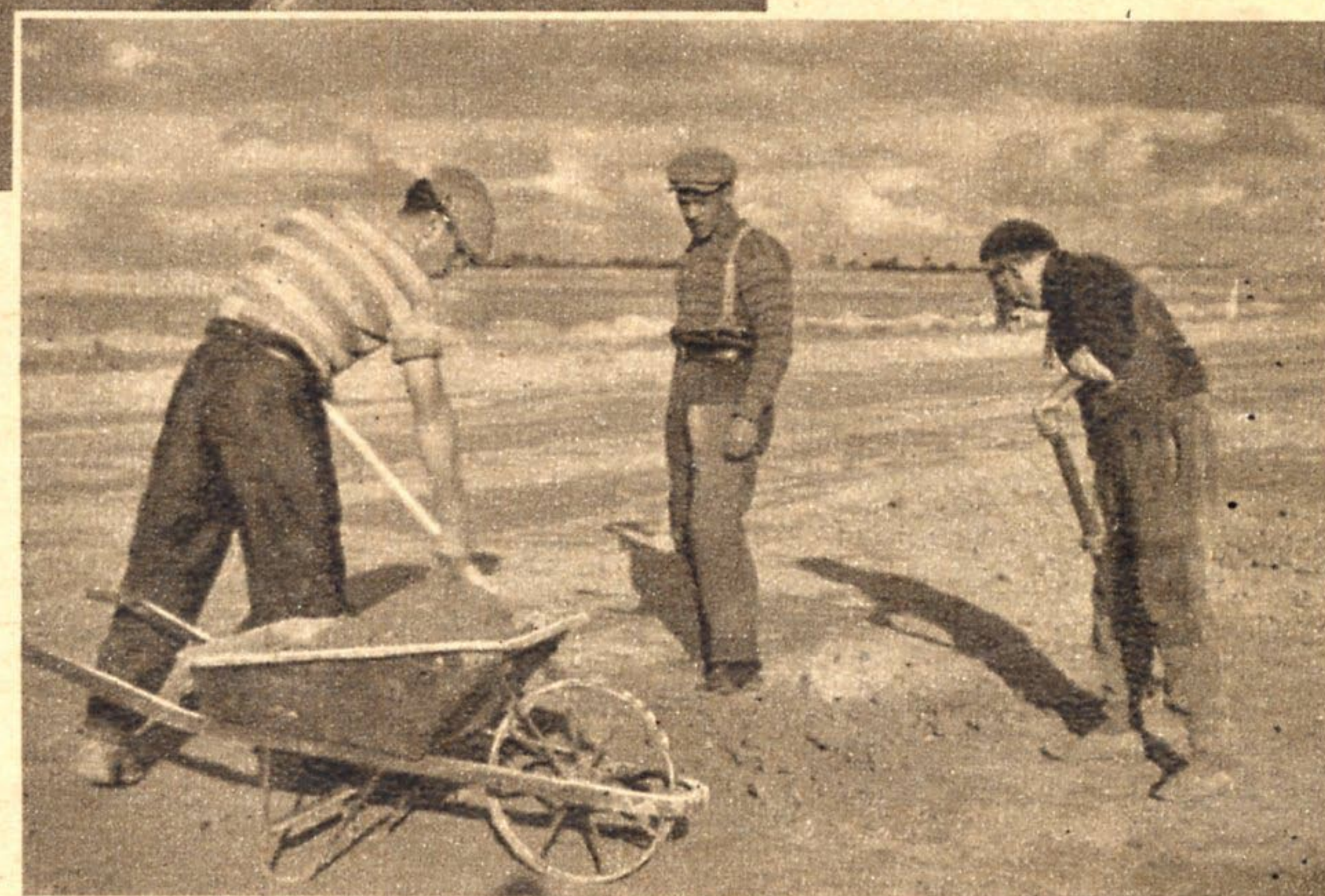
Die Planeure streichen mit langen Hölzern den Zementbrei glatt. Nicht mehr lange, und es werden auf der harten Fläche die schweren Räder unserer Flugzeuge rollen
