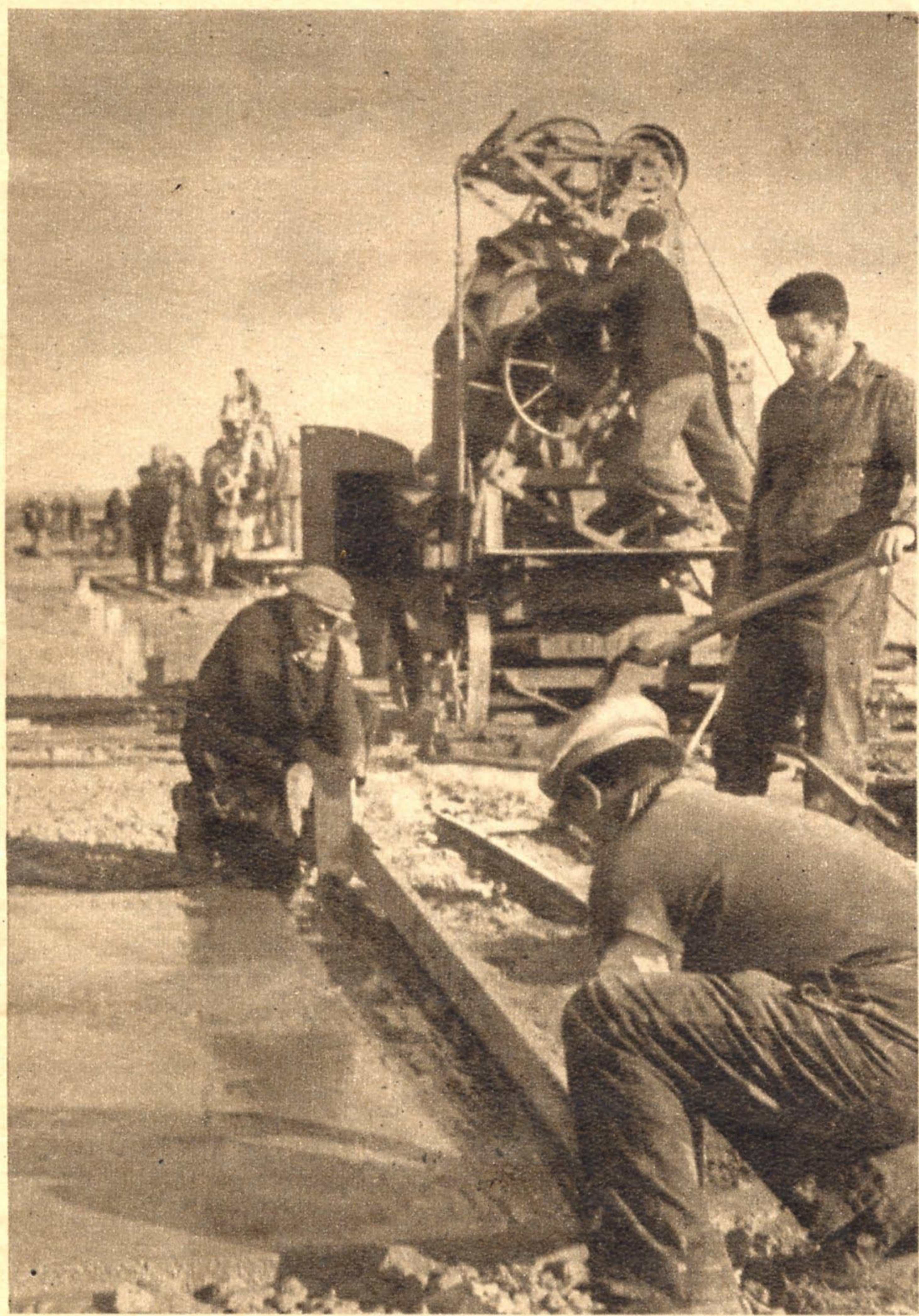
Am laufenden Band wird der Zement zur Mischmaschine geführt, die für den letzten Planstrich den dicken Auftrag liefert
