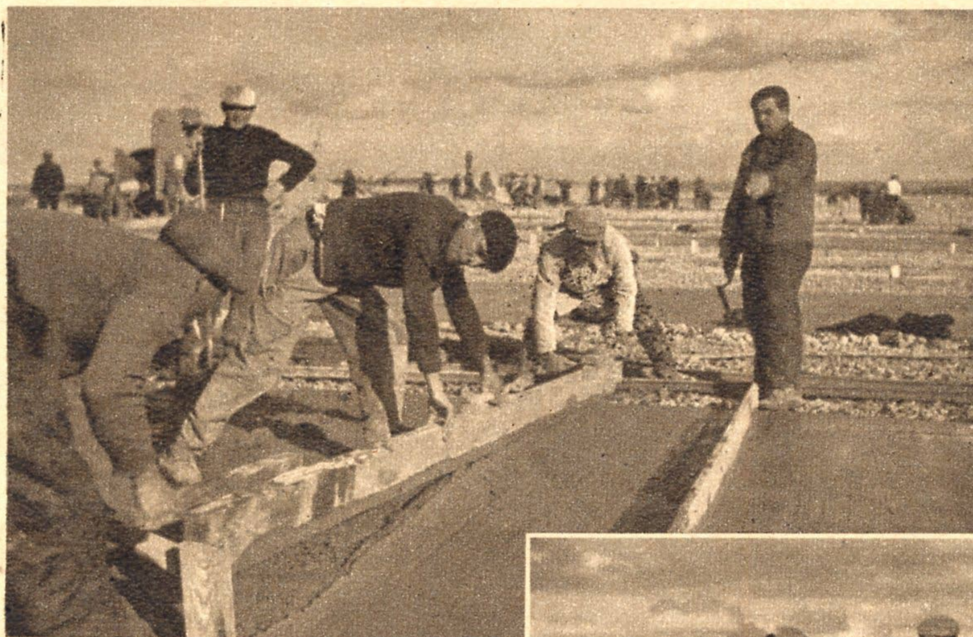
Die Planeure streichen mit langen Hölzern den Zementbrei glatt. Nicht mehr lange, und es werden auf der harten Fläche die schweren Räder unserer Flugzeuge rollen
