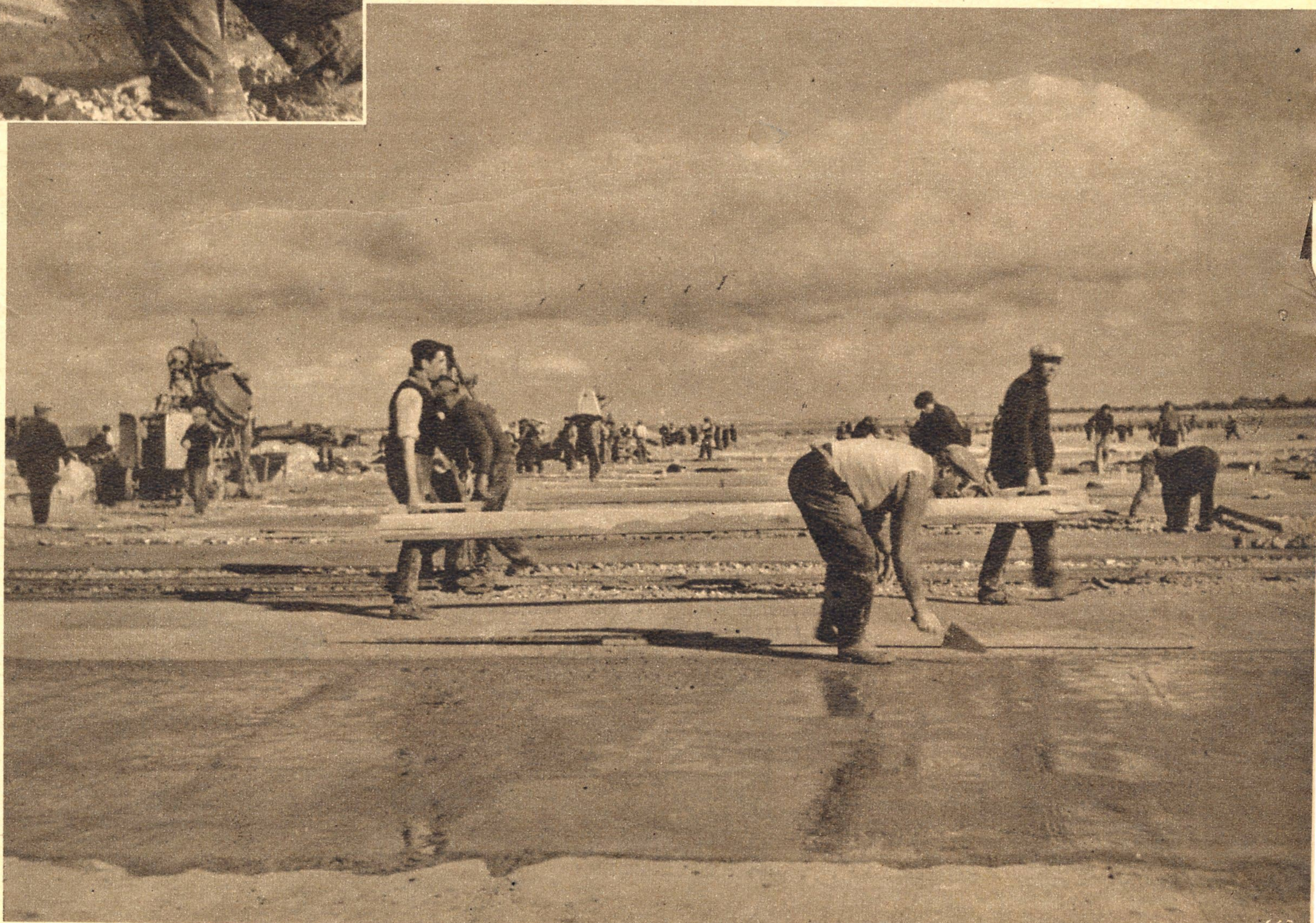
Am laufenden Band wird der Zement zur Mischmaschine geführt, die für den letzten Planstrich den dicken Auftrag liefert
